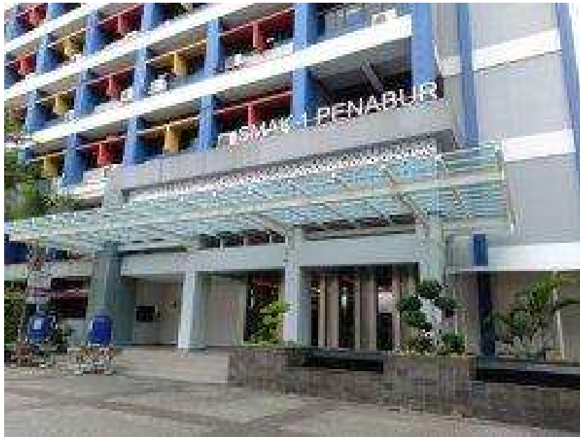
Gedung sekolah SMA Penabur Jakarta Barat.
