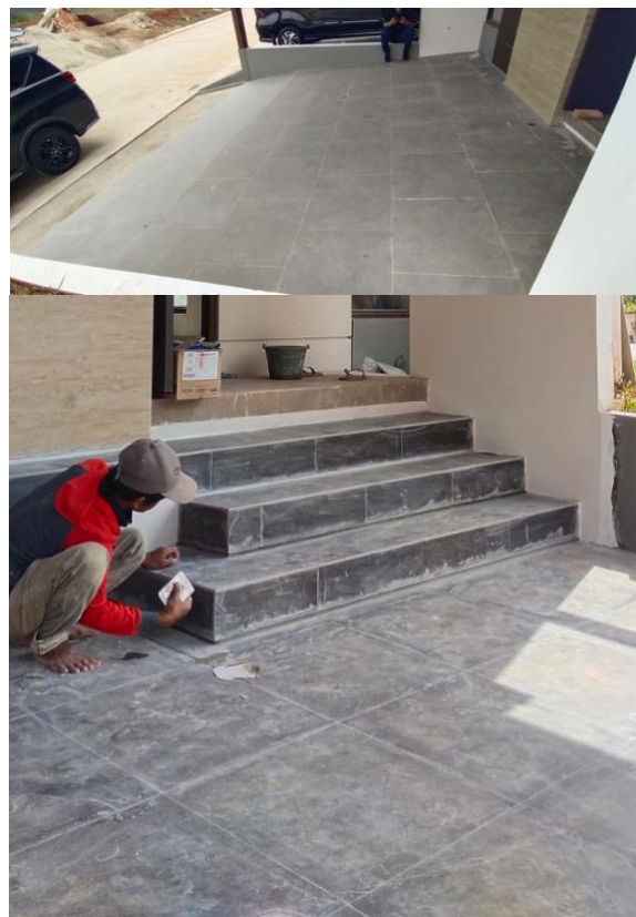
Figure 4. Perkembangan area teras (penurunan level teras)
