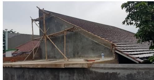
Pekerjaan Rangka & Penutup Atap
