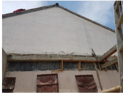
Pekerjaan Struktur ( Ring Balok )
