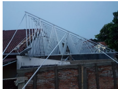
Pekerjaan Struktur ( Ring Balok )
