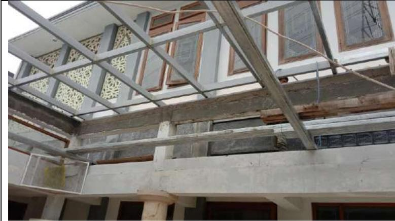
Gambar 22. Pemasangan rangka atap galvanis steel ukuran 5/10 sebagai penopang atap kaca. Dengan jarak modul rangka 90 x 120 cm, mengantisipasi pemasangan kaca tebal 10 mm di atasnya. (Akhir Januari 2023) (Sumber : arsip panitia renovasi)
