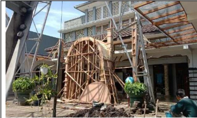
**Gambar 9.** Pekerjaan struktural gerbang, sebagai bagian transisi eksterior dan interior : galian pondasi, pemasangan sloof, kolom-kolom dan balok serta elemen pelengkung. (Sumber : arsip panitia renovasi)
