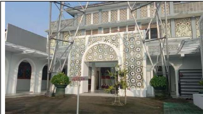
Gambar 34. Hasil akhir desain gerbang masuk, mencakup struktur kolom, balok dan pelengkung beton berikut bidang pengisi berupa elemen dekoratif berbahan GRC cetak yang telah *difinish* dengan cat *emulsion*. (Akhir Maret 2023)
