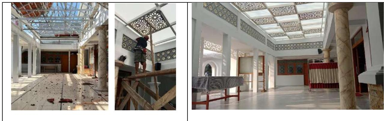
**Gambar 13.** Pekerjaan pembongkaran atap lama dan pemasangan plat ornamen pada bagian bawah plafon kaca, untuk diciptakan suasana interior teras yang lapang, “bersih”, “mengundang” sekaligus representatif. (Pertengahan Januari 2023) (Sumber : arsip panitia renovasi)
