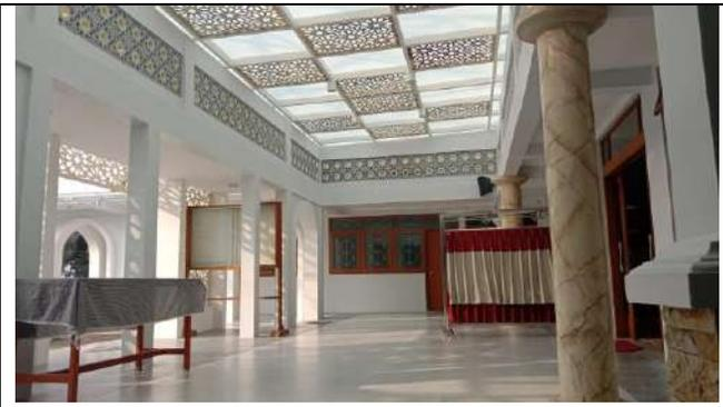
Gambar 35. Hasil akhir desain teras bagian dalam yang mencakup lingkup pekerjaan pemasangan atap skylight baru, pemasangan lantai baru, pemasangan plat ornamen Islami pada rangka ceiling skylight, roster keliling dan sisi gerbang bagian dalam dengan ornament GRC cetak. (Akhir Maret 2023)
