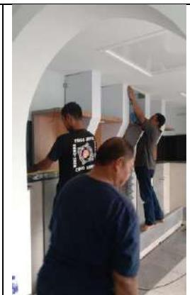
Gambar 46. Pendampingan supervisi pekerjaan *treatment* interior r wudhu di lapangan. Instalasi rak penyimpanan dan *lighting box* (Akhir Maret 2023) (Sumber : arsip panitia renovasi)
