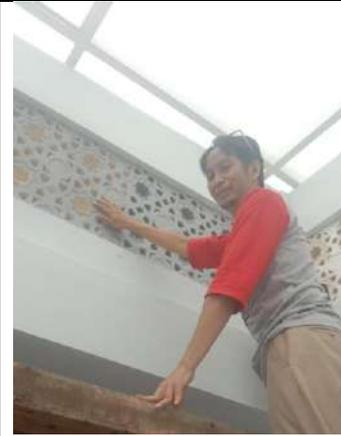
Gambar 23. Pengecekan di lapangan hasil pemasangan double glazed laminated untuk atap skylight tebal 10 mm. Tampilan kaca buram (frosted). (Akhir Januari 2023) (Sumber : arsip panitia renovasi)
