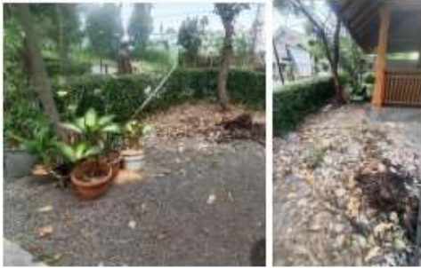
Gambar 3. Kondisi area penyangga pendopo/ gazebo Ahmad Hidayah. Sumber : Dokumentasi Sie PFS MAH.
