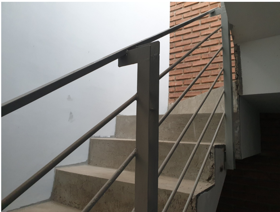
Photo 3 : Tampak plesteran anak tangga sebagai dasar pemasangan finishing anak tangga kayu meranti di permukaannya
