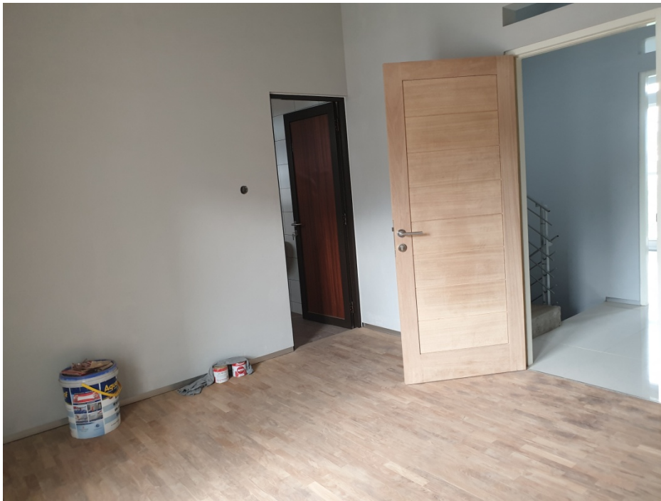
Photo 5 : Tampak pemasangan lantai parquette kayu jati pada ruang tidur utama lantai 2
