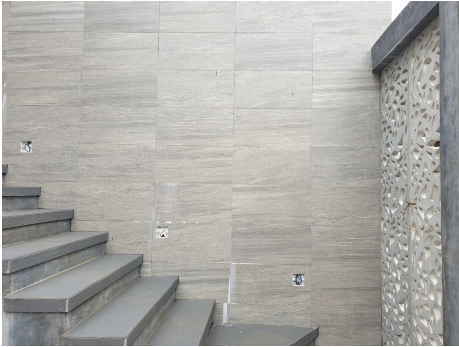
Photo 2: Tampak finishing dinding keramik dan elemen dekoratif GRC pada tangga main entrance rumah tinggal
