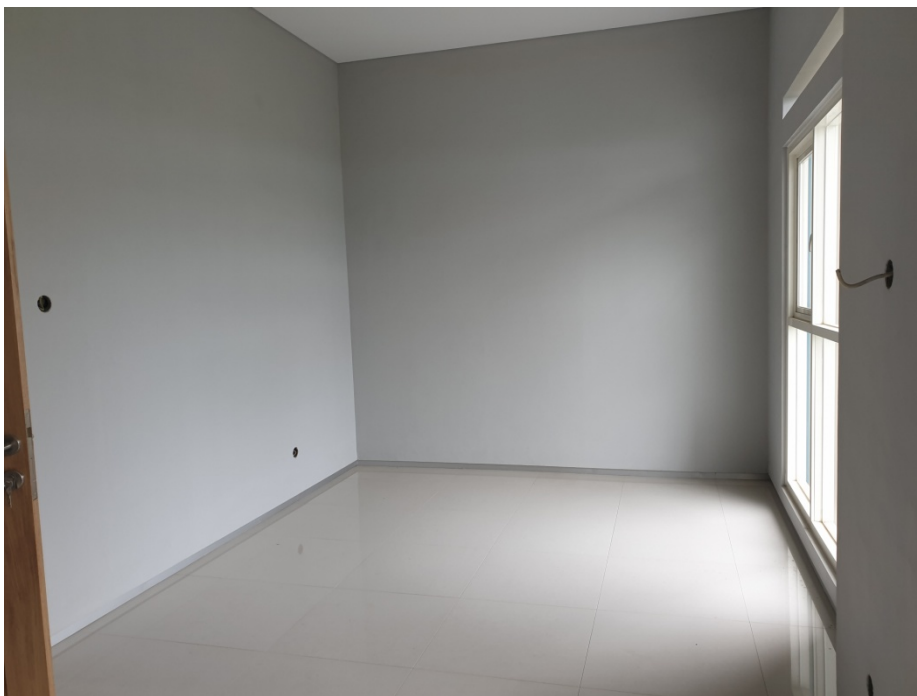
Photo 6 : Tampak finishing keramik 60x60 pada ruang tidur anak lantai 2
