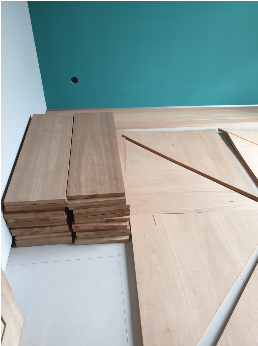
Photo 4 : Tampak papan kayu meranti yang telah dipola sesuai anak tangga lantai 2 menuju lantai 3
