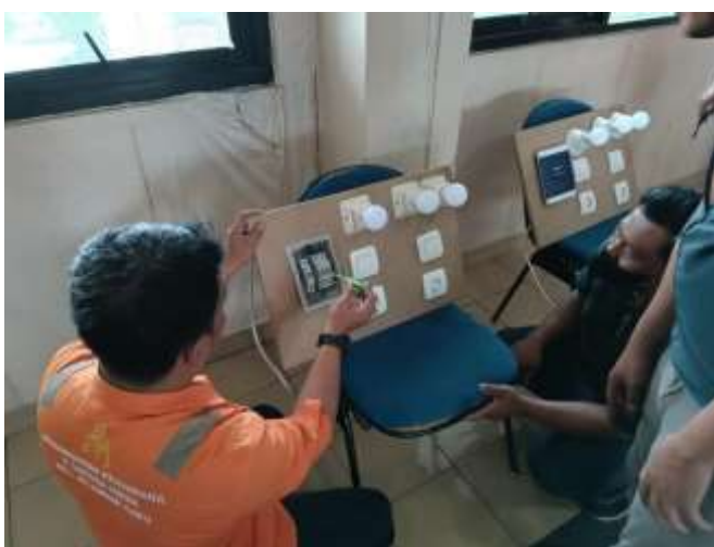
Pengetesan sistem karena ada bagian yang tidak berfungsi (troubleshooting)
