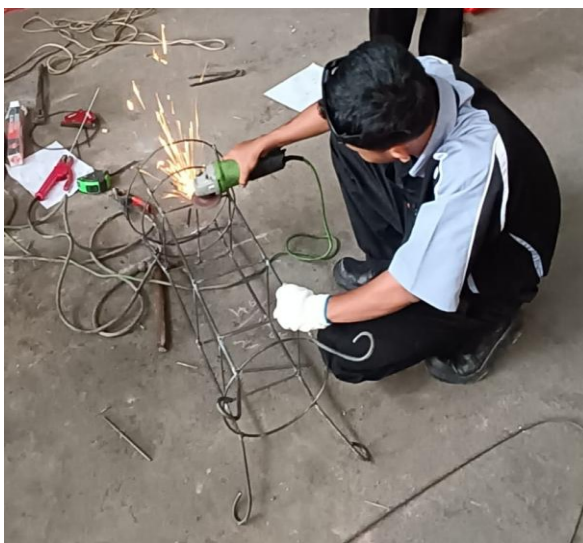
Gambar 9. Menggerinda Kampuh Las
