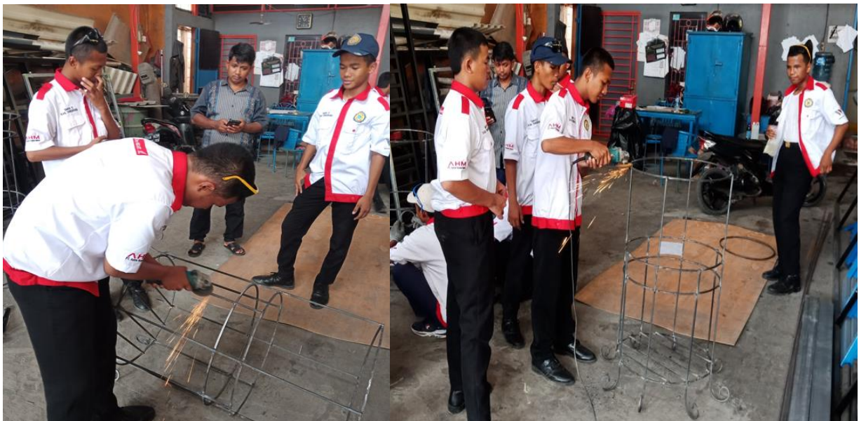
Gambar 14. Proses Penghalusan Sambungan
