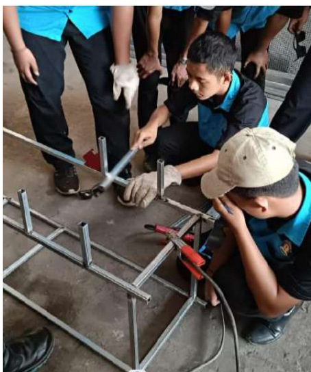
Gambar 24. Penyambung Bahan Menggunakan Teknik Pengelasan
