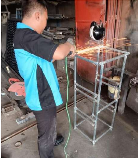
Gambar 26. Menggerinda Kampuh Las
