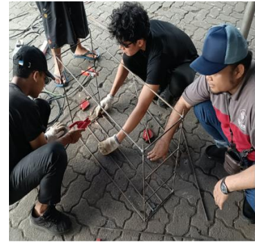
Gambar 11. Mengelas Batang Ambalan
