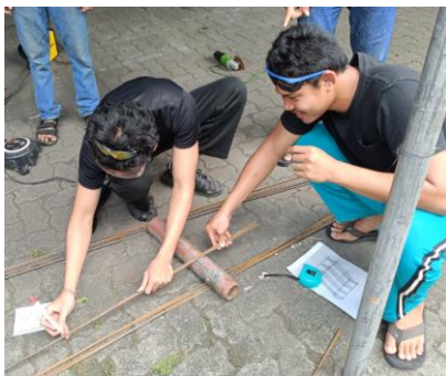
Gambar 3. Mengukur Panjang Bahan
