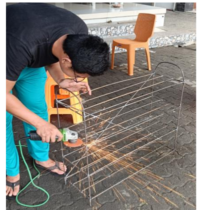
Gambar 15. Menggerinda Kampuh Lasan
