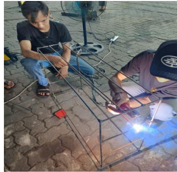
Gambar 10. Mengelas Batang Ambalan
