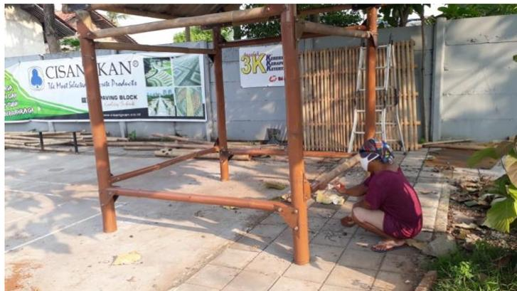
Gambar 2.8. Pengecatan saung bambu
