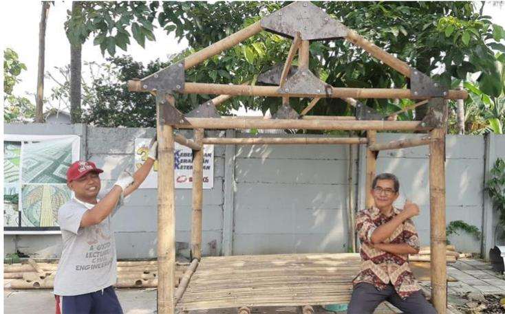
Gambar 2.5. Pemasangan rangka kuda-kuda pada tiang saung
