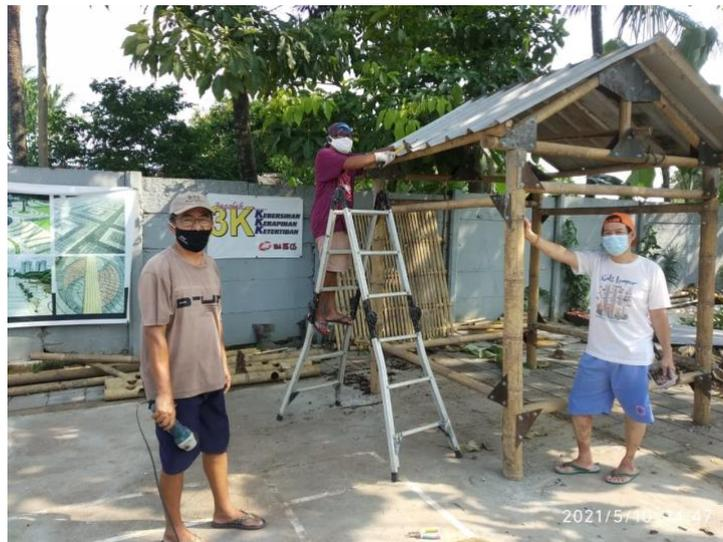
Gambar 2.6. Pemasangan atap saung bambu
