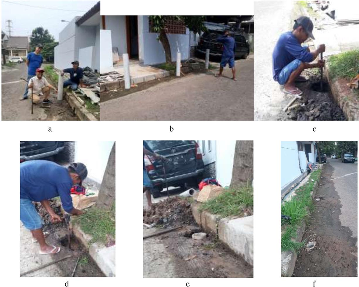
Gambar 4. Proses pemasangan buis beton a) persiapan, b) penentuan jarak, c) penggalian linggis, d) penggalian bor, e) pemasangan, f) hasil akhir pemasangan
