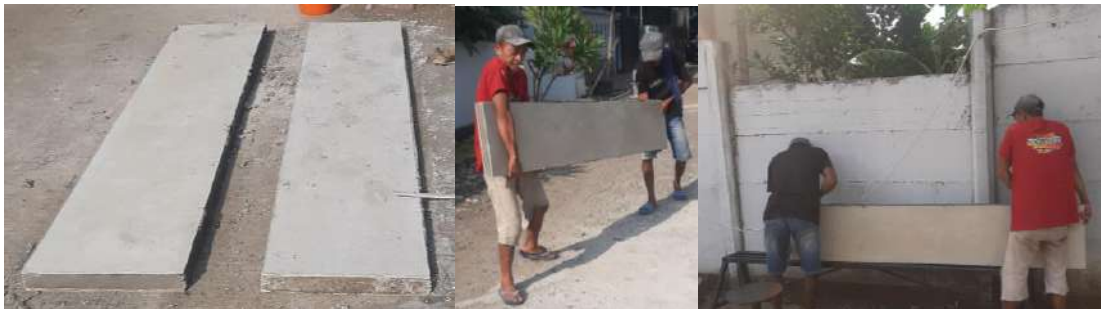
Gambar 8. Panel ringan yang sudah kering dan siap dipasang
