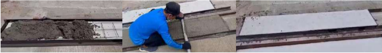
Gambar 7. Proses pencetakan dan pemadatan adukan panel ringan
