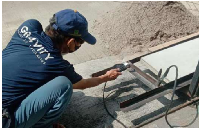
Gambar 5. Pembuatan cetakan cetakan panel
