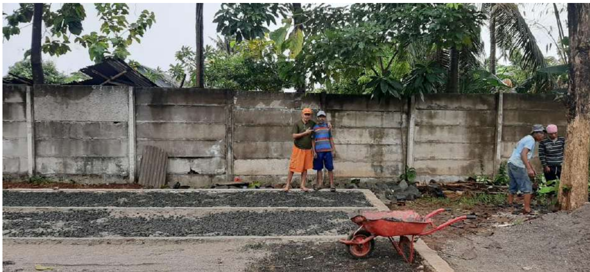
Gambar 11. Pemasangan jalur pengecoran
