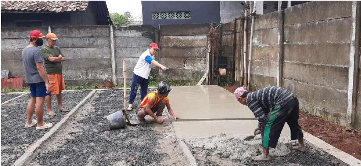
Gambar 16. Perataan beton di lapangan
