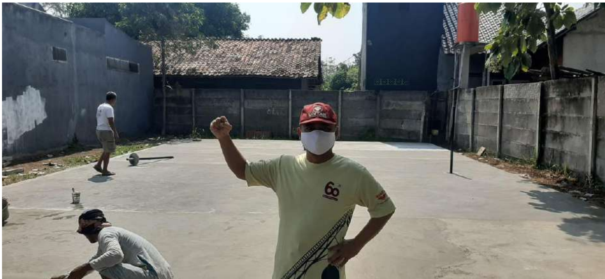
Gambar 17. Pekerjaan pembetonan selesai
