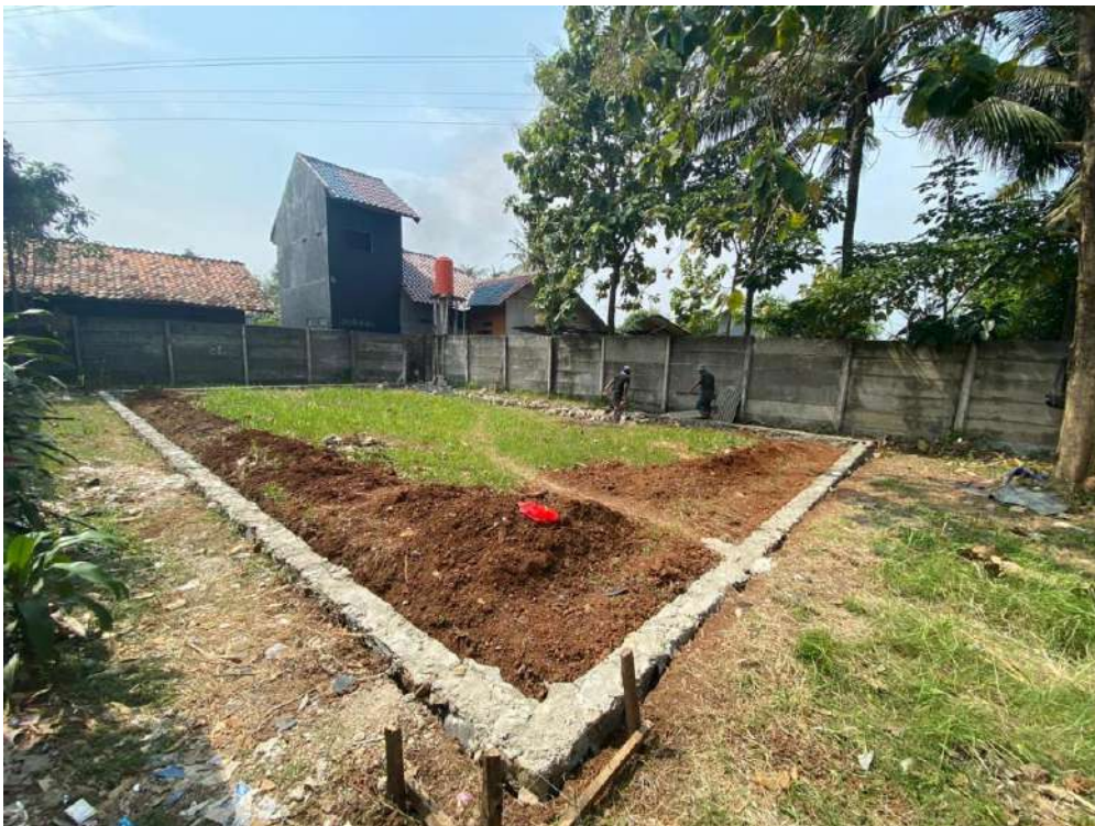
Gambar 9. Pemasangan fondasi batu kali
