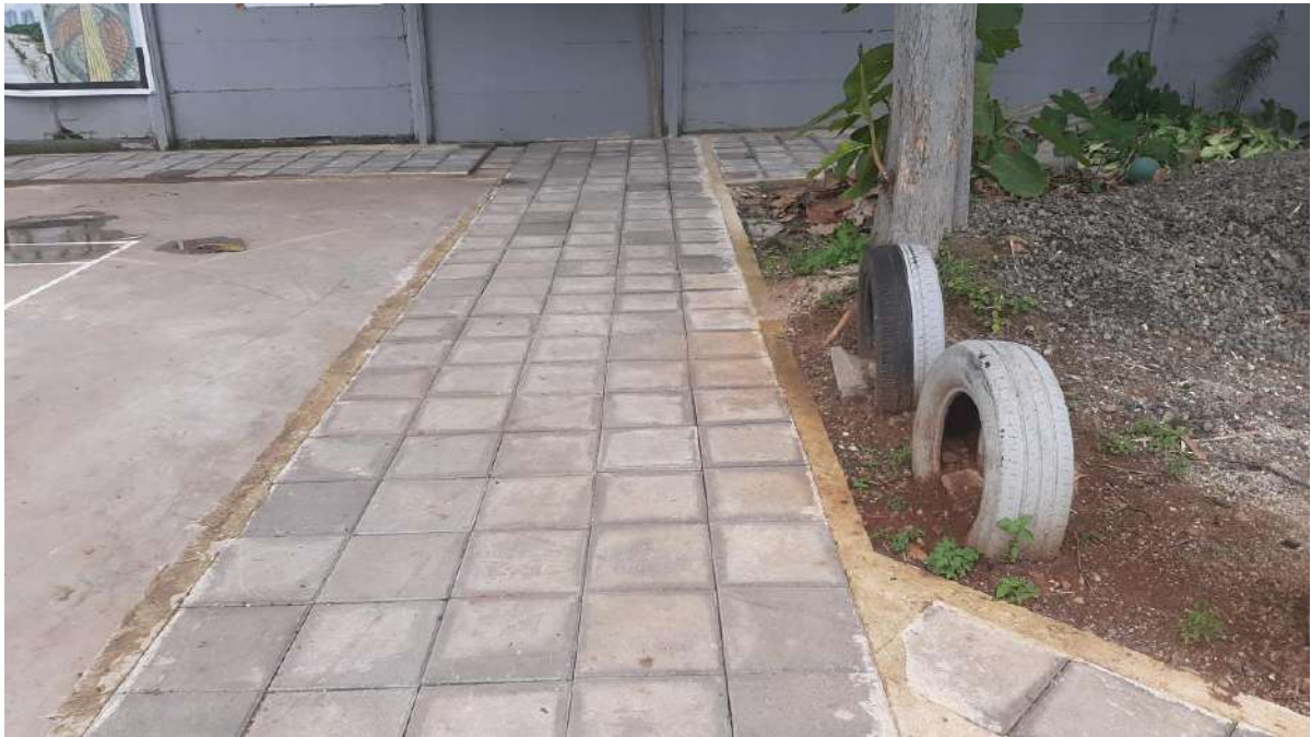
Gambar 21. Pemasangan paving sisi depan lapangan
