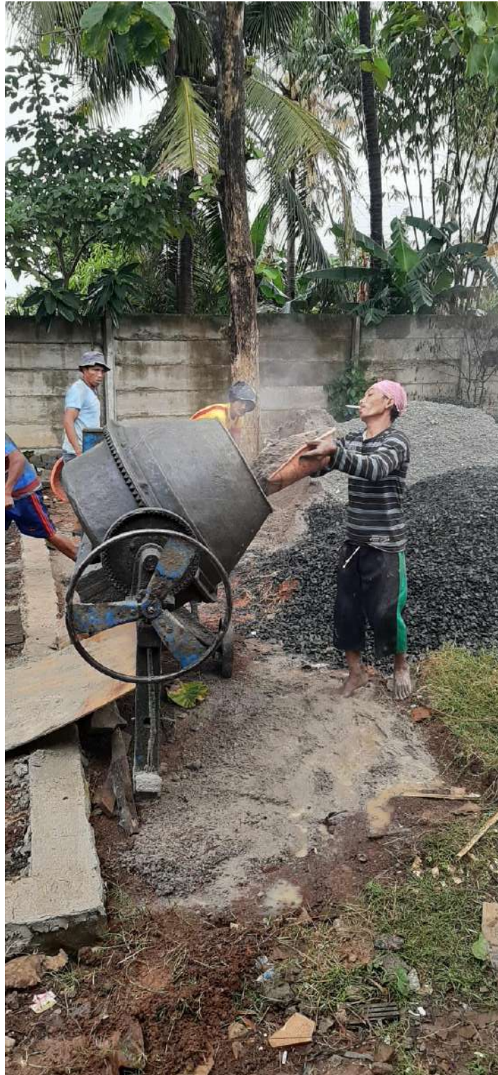
Gambar 13. Pemasukan material beton ke mesin pengaduk
