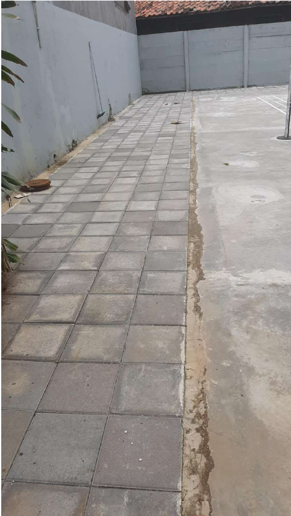
Gambar 20. Pemasangan paving sisi kiri lapangan
