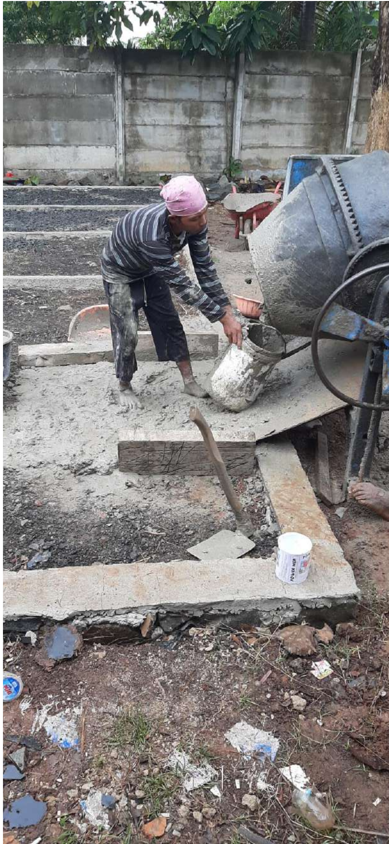
Gambar 14. Penuangan beton ke ember pengangkut
