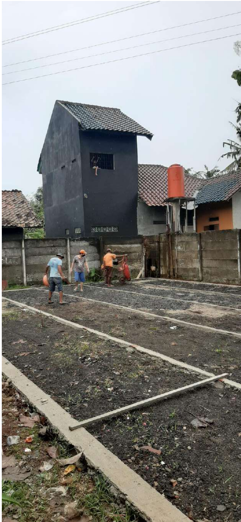
Gambar 15. Penuangan beton ke lapangan
