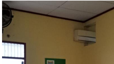
Gambar 8. Unit Pendingin Ruangan 1 Unit untuk 2 Ruangan
