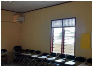
Gambar 7. Ventilasi dan Roster Ditutup Lembaran Plastik
