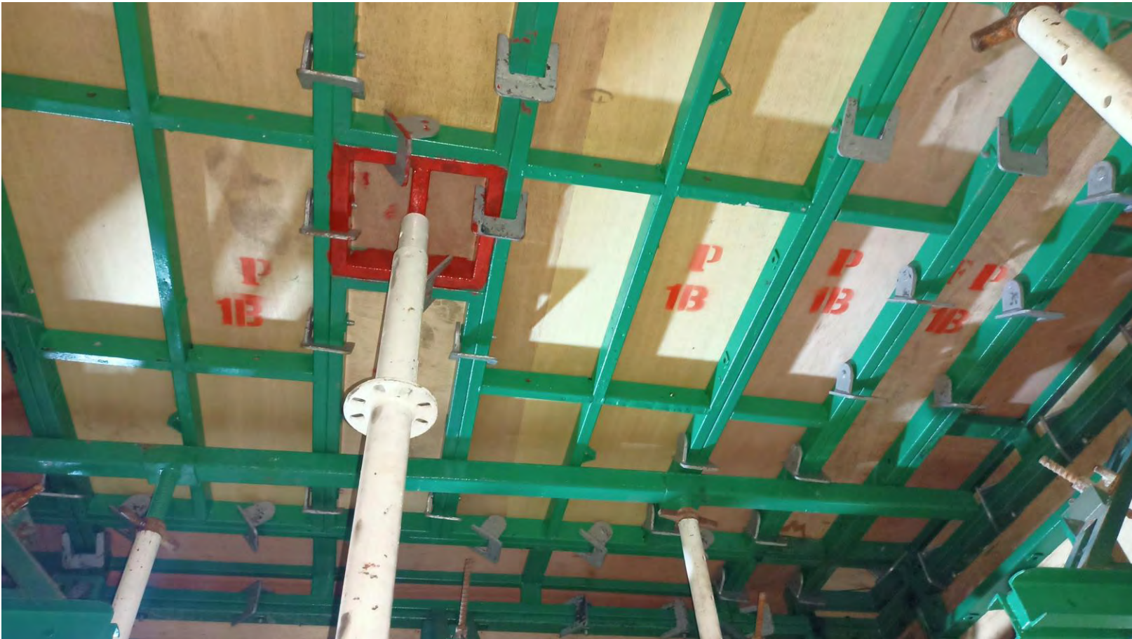
FOTO SUPPORT FIX SHORING SEBELUM BEKISTING DI BONGKAR
