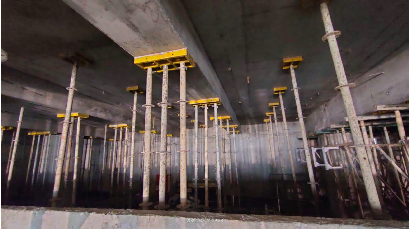
FOTO SUPPORT FIX SHORING SETELAH BEKISTING DI BONGKAR
