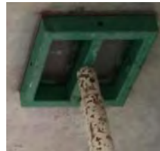
Foto Sisi Atas Fix Shoring
