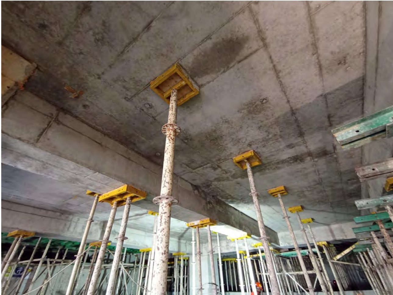
FOTO SUPPORT FIX SHORING SETELAH BEKISTING DI BONGKAR
