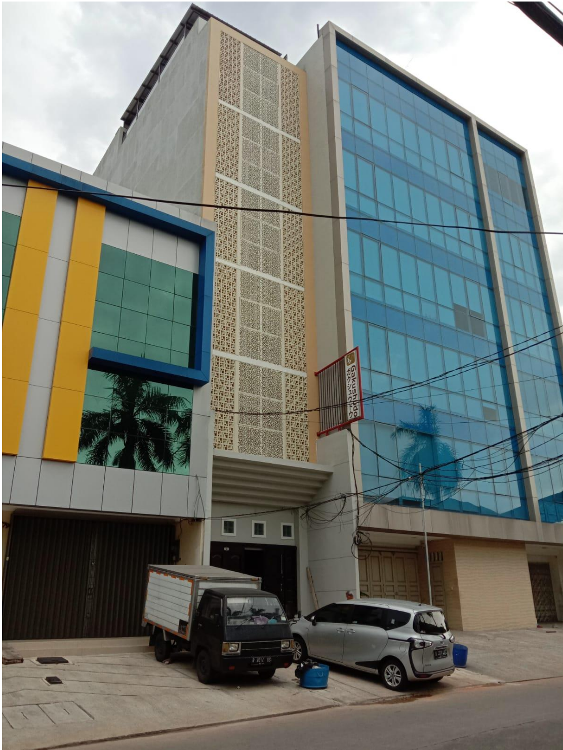
Gambar 4. Hasil pemasangan Papan Nama Gedung Kantor Gakushudo.
