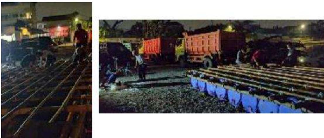
**Gambar 9** Pemasangan *flooring* dari rangkaian bambu untuk pijakan
