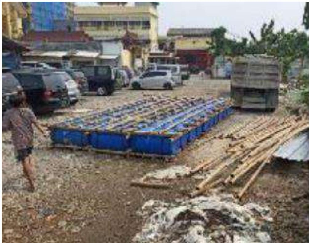
**Gambar 11** Pemasangan rangka barrel apung dan struktur bawah
