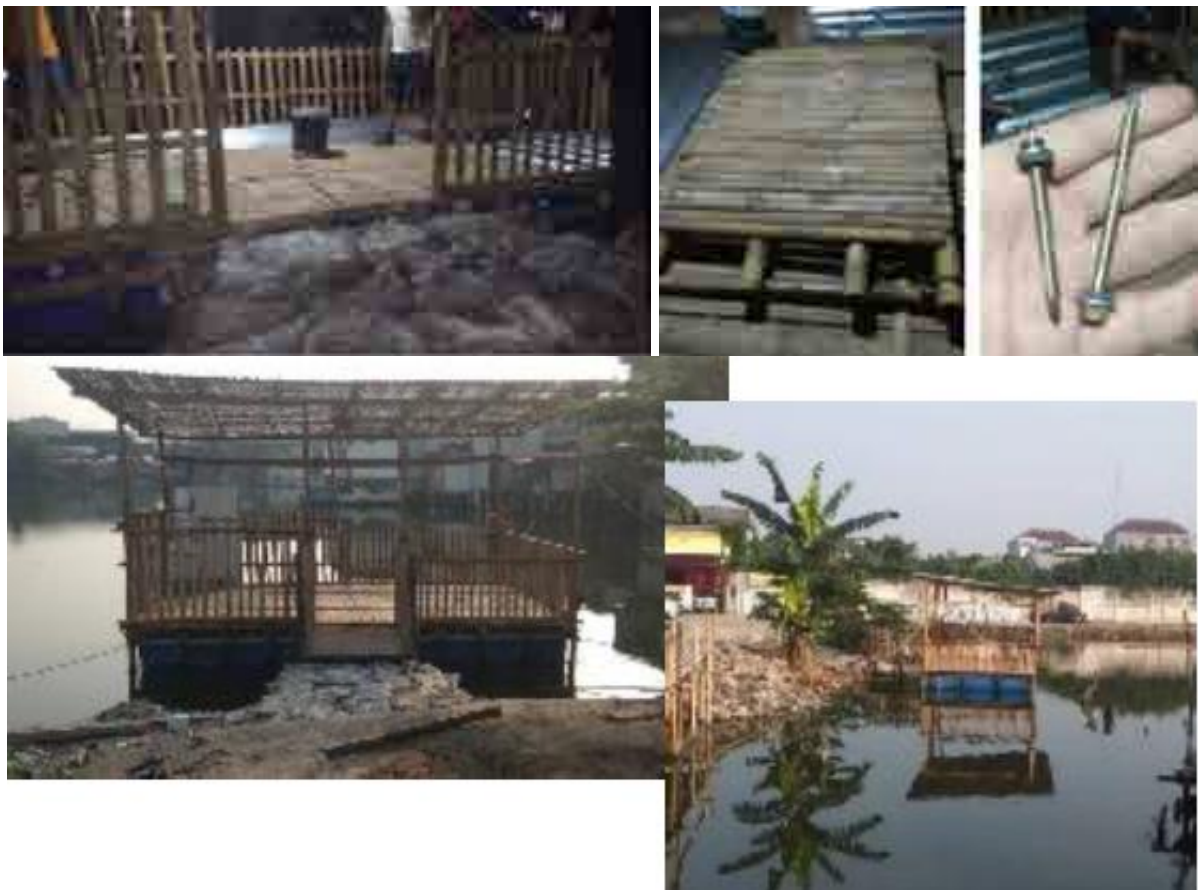
Gambar 16 Pembuatan rangka jembatan penghubung dari darat ke bangunan yang terapung sudah selesai
