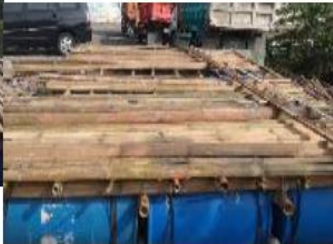
Gambar 12 Pemasangan rangka flooring dengan serutan bambu yang diperhalus
