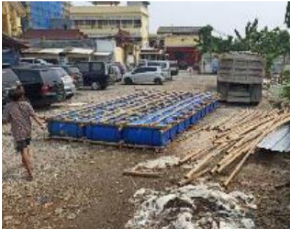
Gambar 11 Pemasangan rangka barrel apung dan struktur bawah
