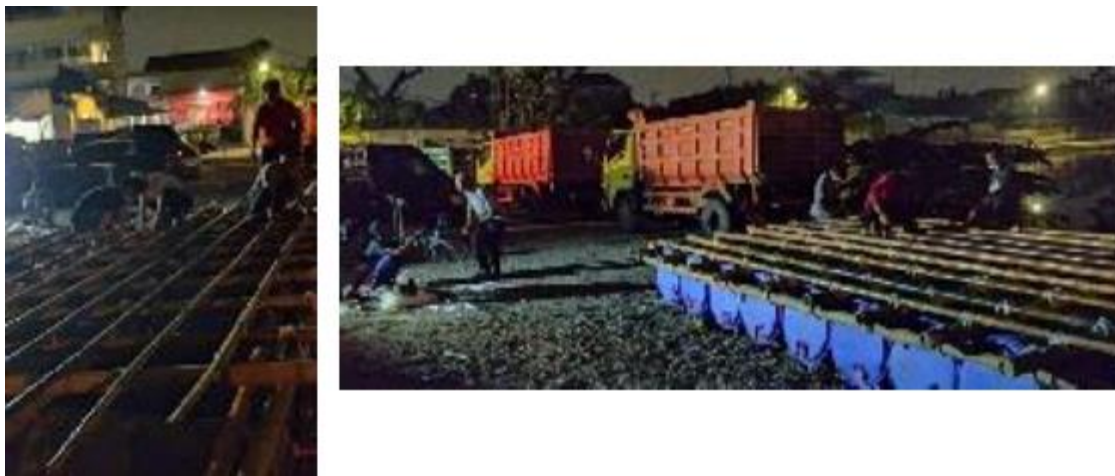
Gambar 9 Pemasangan flooring dari rangkaian bambu untuk pijakan
