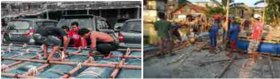
Gambar 8 Proses Penyusunan Bambu pada Area Desain
