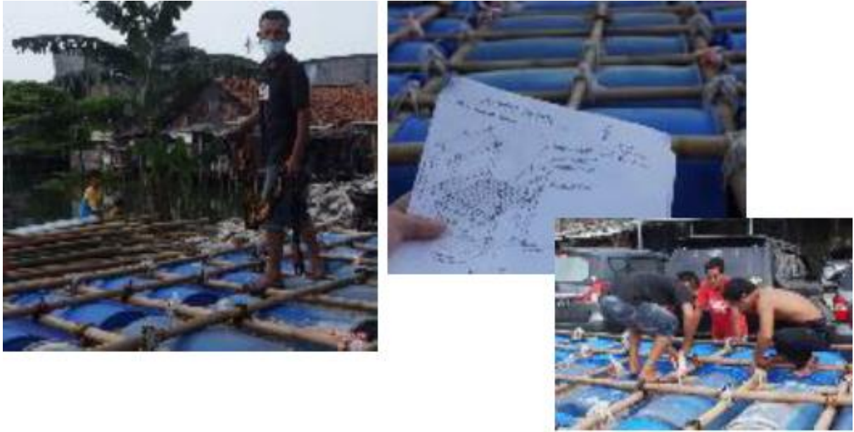
Gambar 10 Perapian instalasi setelah flooring
