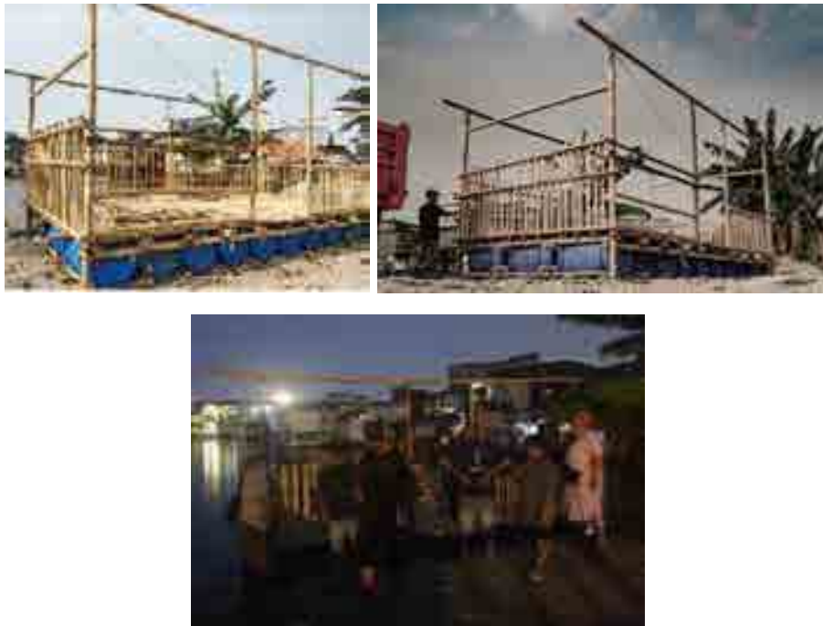
Gambar 14 Bangunan mulai dipondahkan secara terdorong ke air
