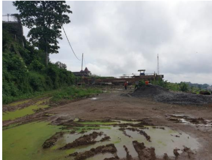
Gambar 2. Lokasi Pembangunan Masjid sisi Utara
