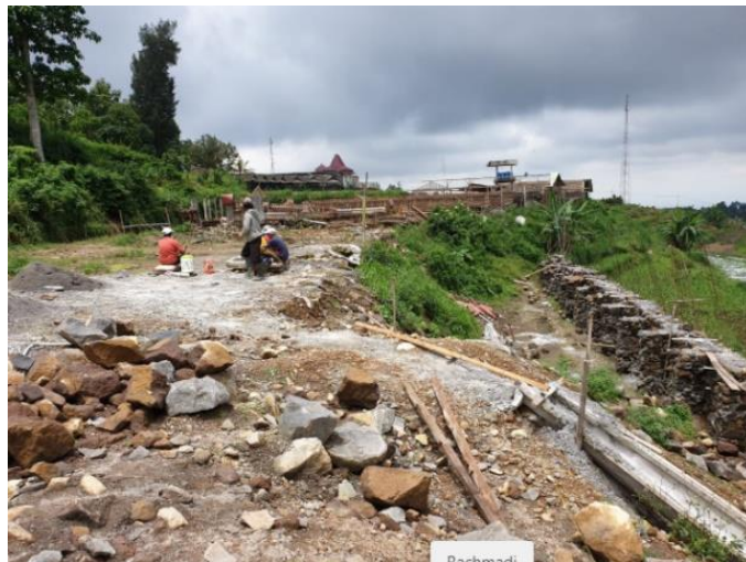
Gambar 3. Lokasi Pembangunan Masjid sisi Selatan
