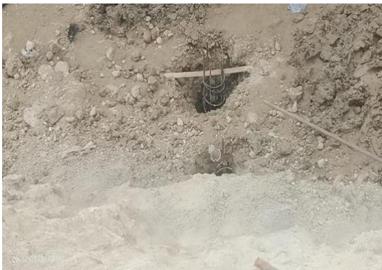
Gambar 12. Pembuatan Tiang Bor
