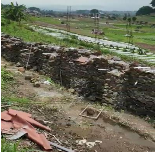
Gambar 4.2. Pembangunan dinding penahan tanah di lokasi masjid saat belum di urug
