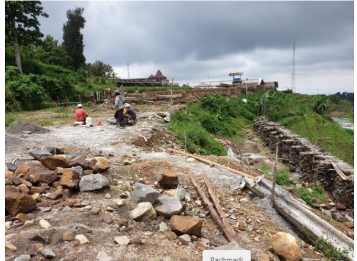
Gambar 4.2. Pembangunan dinding penahan tanah di lokasi masjid saat belum di urug
