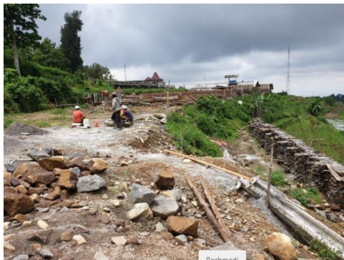
Gambar 3. Lokasi Pembangunan Masjid sisi Selatan
