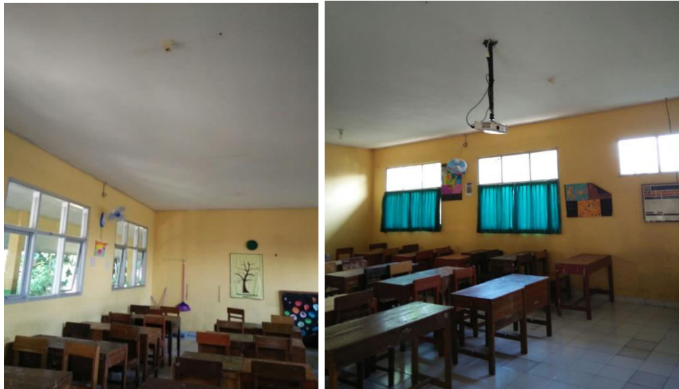
Gambar 5.1 Ruang kelas SMP N 2 Cibinong sebelum retrofit lampu
