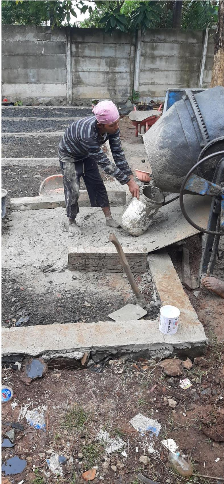
Gambar 14. Penuangan beton ke ember pengangkut
