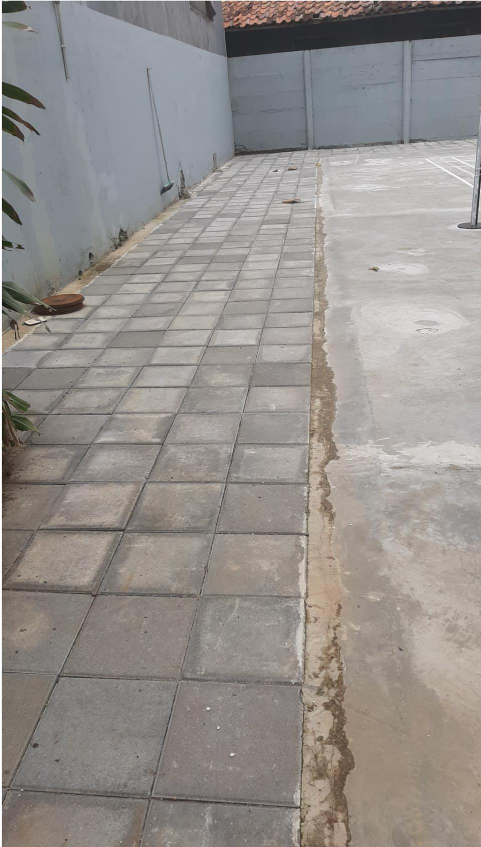
Gambar 20. Pemasangan paving sisi kiri lapangan
