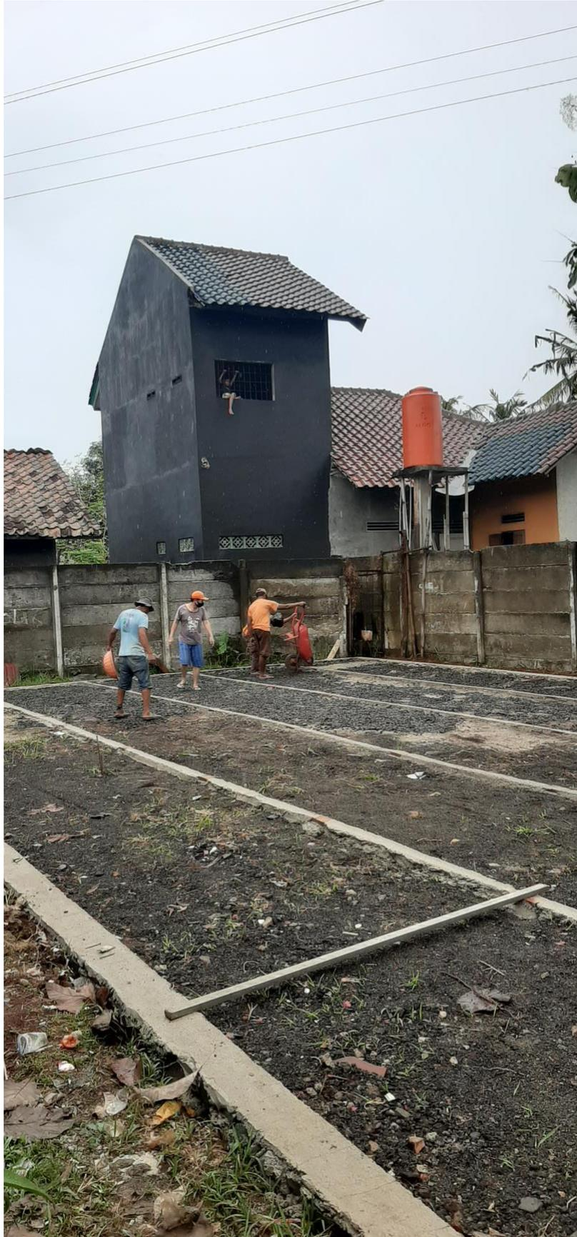
Gambar 15. Penuangan beton ke lapangan
