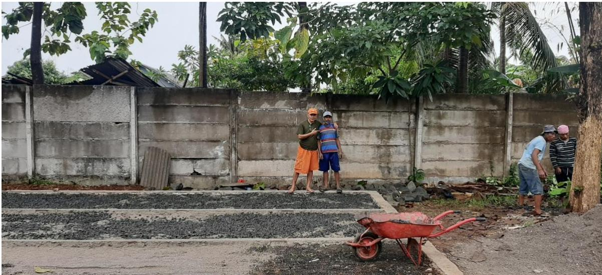
Gambar 11. Pemasangan jalur pengecoran
