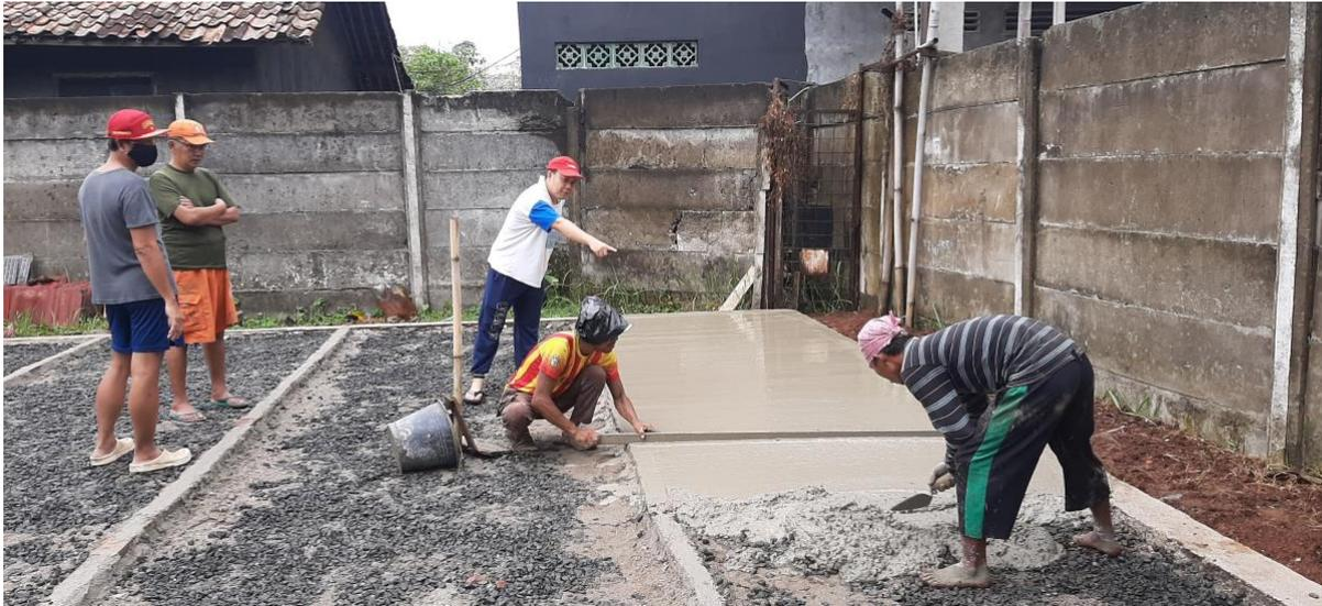
Gambar 16. Perataan beton di lapangan
