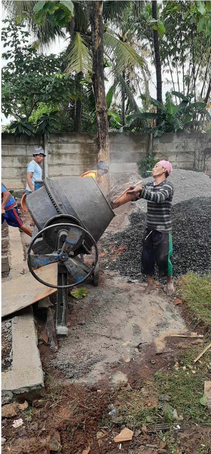
Gambar 13. Pemasukan material beton ke mesin pengaduk
