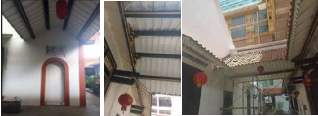
Gambar 10. Hasil Akhir Pekerjaan Sesuai dengan Peraturan Undang-undang nomor 11 tahun 2010 (Sumber: Foto Pribadi, 2022)
