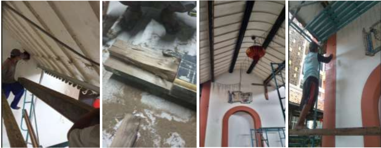
Gambar 6. Proses Penurunan, penyambungan, pemasangan kembali, diberi anti rayap dan pengecatan Sumber: Dokumentasi pribadi 2023
