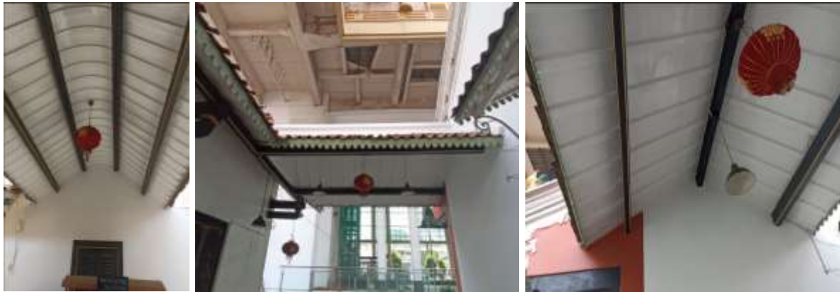
Gambar 7. Pemasangan kembali dan pengecatan telah selesai Sumber: Dokumentasi pribadi 2023
