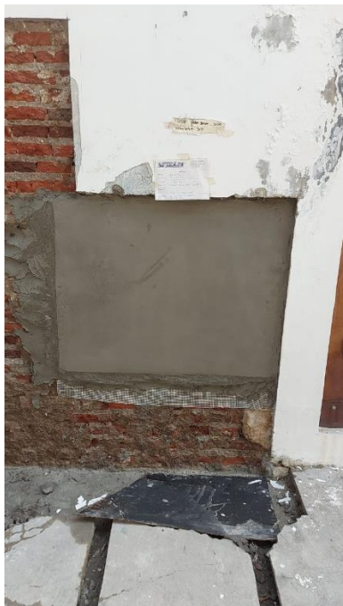
Gambar 10. Plesteran dengan Trassram (Sumber: Data Pribadi, 2021)
