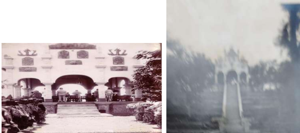
Gambar II.7. Foto Balai Kapal saat selesai pembangunan (kiri) dan pada tahun 1954 sebelum terkena bencana alam gempa bumi (kanan) (Sumber: Dokumentasi AA Bagus Ngurah Agung & dokumentasi keluarga peneliti 1954)
