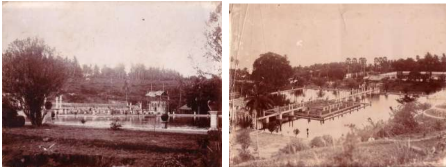
Gambar IV.11. Saat pembangunan Bale Gili Taman Soekasada Ujung Karangasem (Sumber: Dokumentasi keluarga kerajaan Karangasem, 2022)
