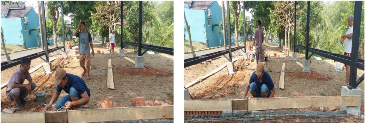
Gambar 4.8. Proses pembuatan sloop sekeliling gangunan
