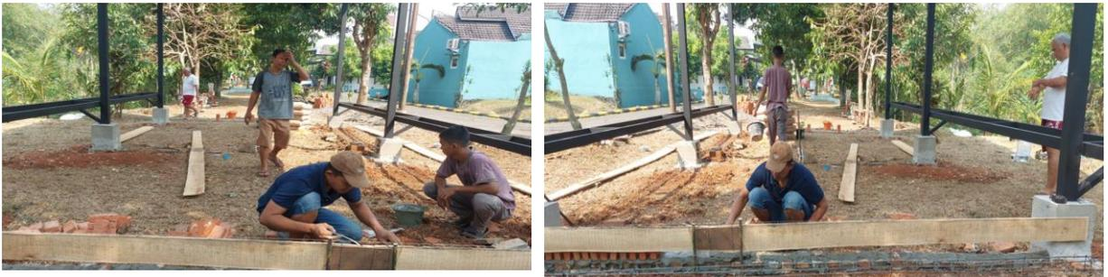
Gambar L.2.6. Pemasangan sloof sekeliling bangunan
