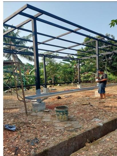
Gambar L.2.4. Pembangunan kerangka dan pengecatan baja
