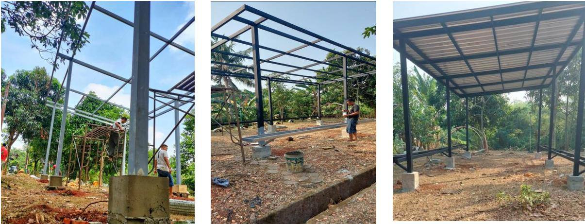
**Gambar 13.** Pemasangan sloof disekeliling bangunan
