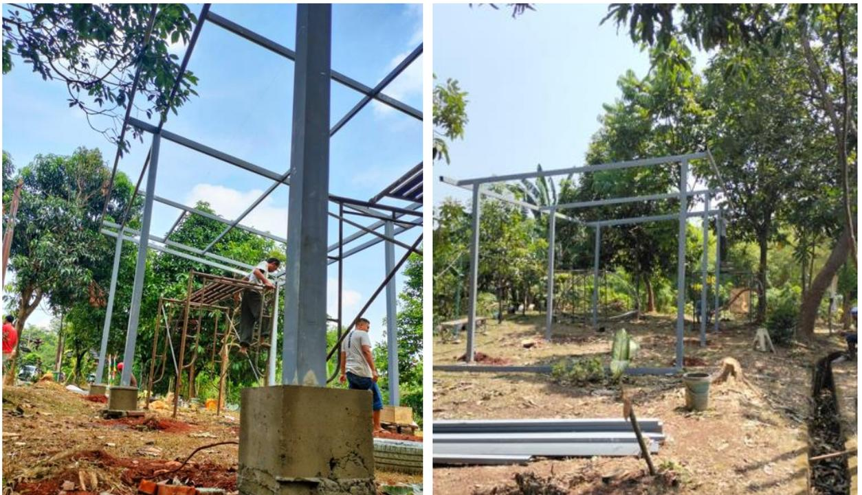
Gambar 4.5. Proses pembuatan fondasi dan kerangka baja untuk struktur bangunan
