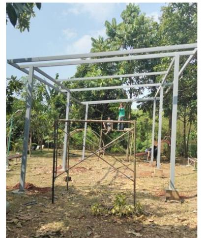
Gambar L.2.3. Pembangunan fondasi dan rangka baja
