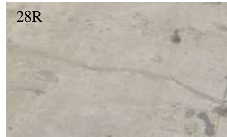
Gambar 4.5 Gambar Kerusakan Perkerasan Jalan Seksi 2
