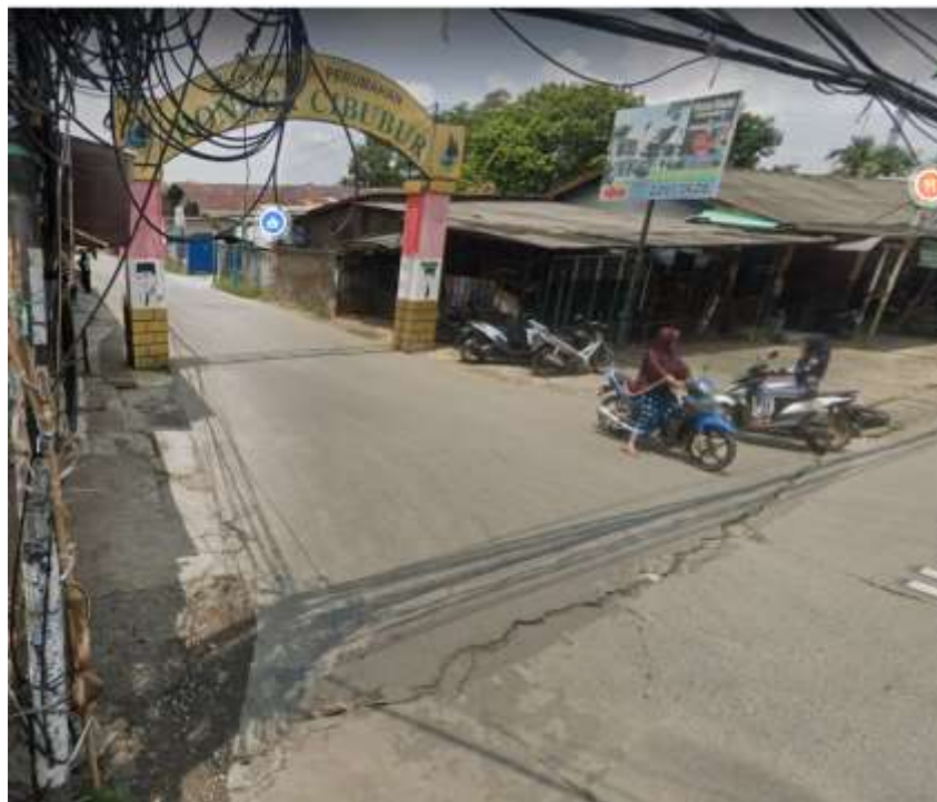
Gambar 1.4 Kondisi Jalan Masuk Perumahan Pondok Cibubur
