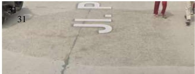
Gambar 4.3 Gambar Kerusakan Perkerasan Jalan Seksi 1
