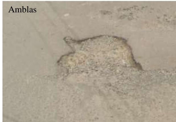
Gambar 4.7 Gambar Kerusakan Perkerasan Jalan Seksi 3
