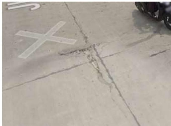
Gambar 1.6 Kerusakan Perkerasan Kaku di Jalan Pondok Cibubur
