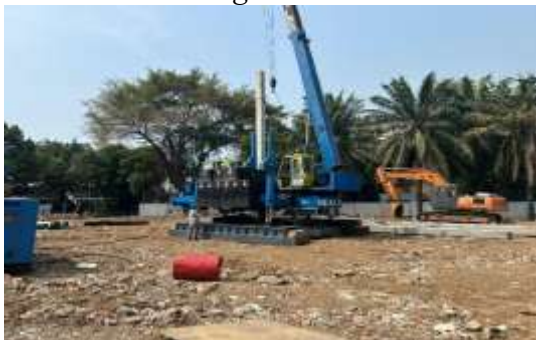
Gambar 5 Proses Pemancangan
