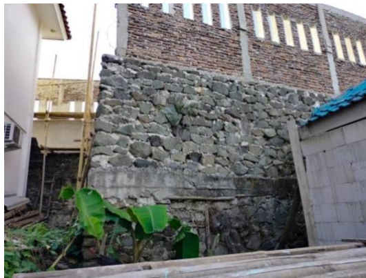
Gambar 4. Dinding penahan tanah yang sudah dibangun di sisi kanan lahan dilihat dari sisi luar
