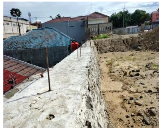
Gambar 5. Dinding penahan tanah yang sudah dibangun pada sesi 4 dilihat dari dalam lahan
