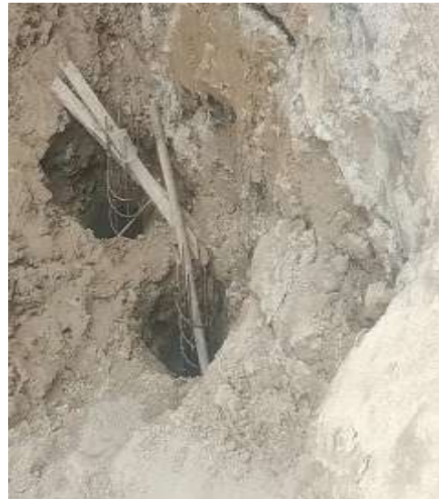
Gambar 13 Lubang tiang bor dan pembesiannya
