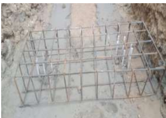
Gambar 14 Pemasangan tulangan pilecape
