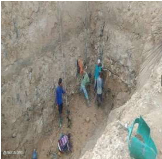
Gambar 12 Penggalian dan pembuatan tiang bor disisi dalam dinding penahan tanah
