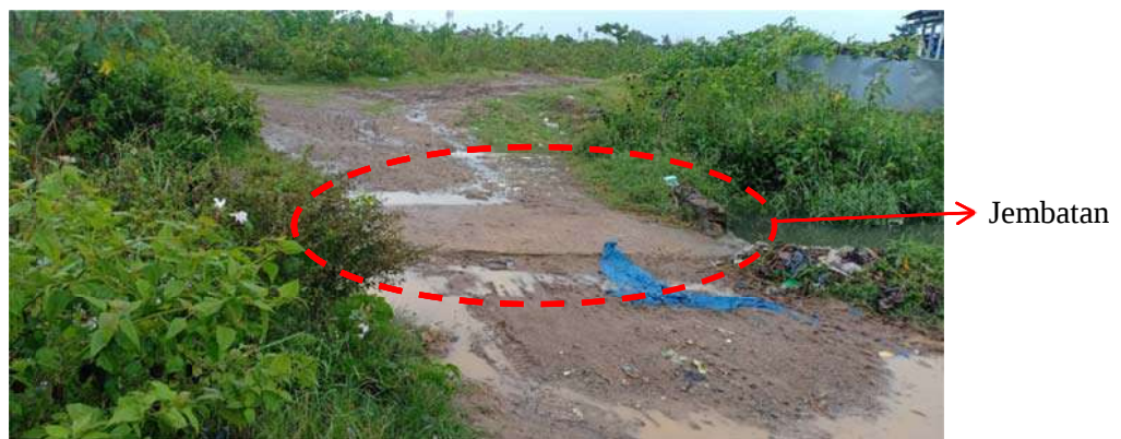
Gambar 1.13 Kondisi Jembatan Penghubung ke Blok B yang Berada di depan Indomart (Sumber: Survei Lapangan, Februari 2022)
