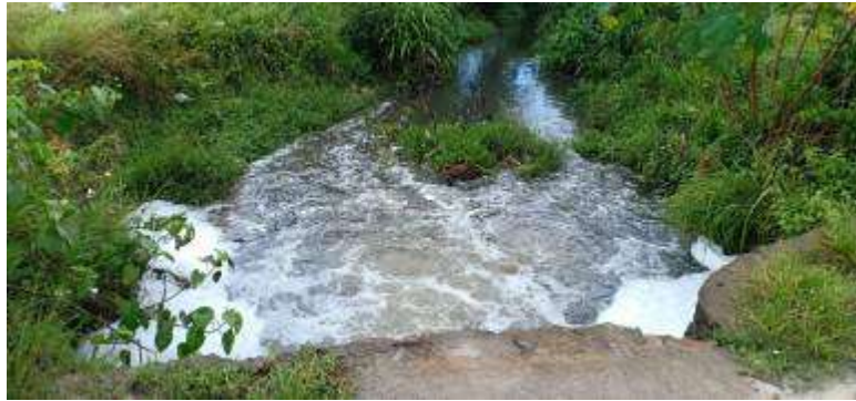
Gambar 4. Kondisi Saluran Induk Perumahan Sumber: Survei Lapangan, Februari 2022
