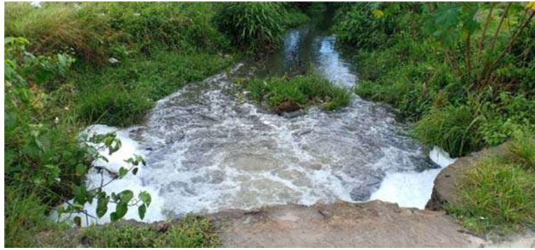
Gambar 1.11 Kondisi Saluran Induk Perumahan (Sumber: Survei Lapangan, Februari 2022)
