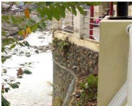
Gambar 1.9 Penguat Beton dan Dinding Turap untuk Pencegahan Erosi (Sumber: Aprillia dkk, 2020: 408)
