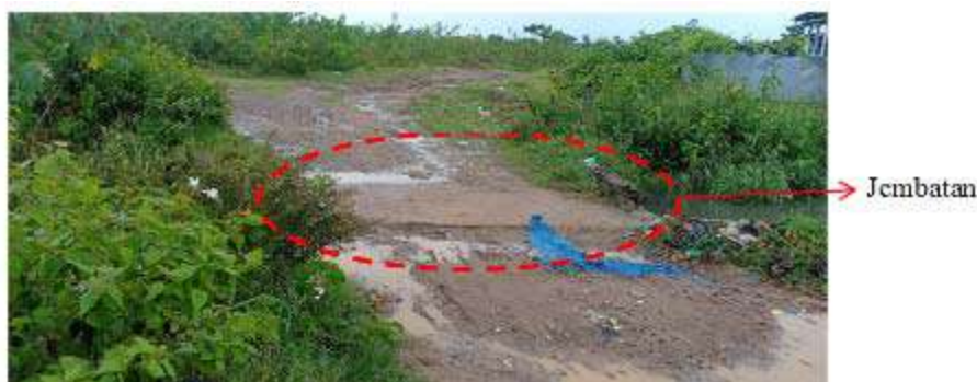
Gambar 6. Kondisi Jembatan Penghubung ke Blok B yang Berada di depan Indomart Sumber: Survei Lapangan, Februari 2022
