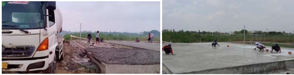
Gambar 4.7 Pengecoran dan Perapian Cor Beton (Dana dari Developer ) (Sumber: Dokumentasi, September 2022)
