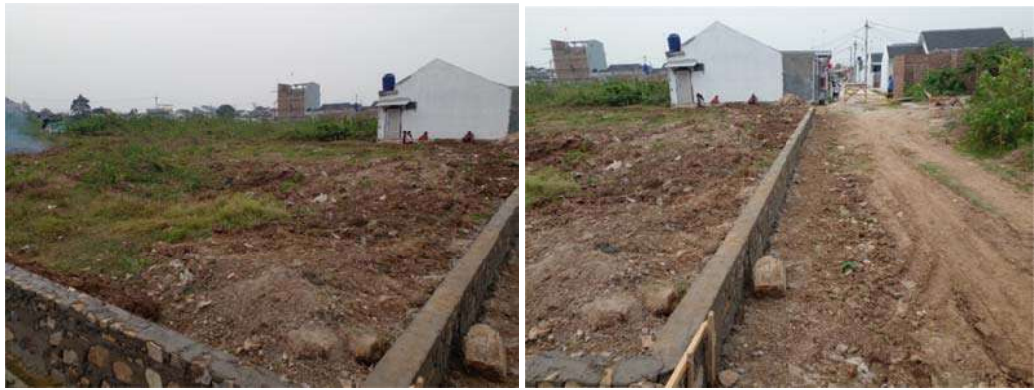
Gambar 4.3 Pembangunan Pondasi (Dana dari Developer ) (Sumber: Dokumentasi, September 2022)
