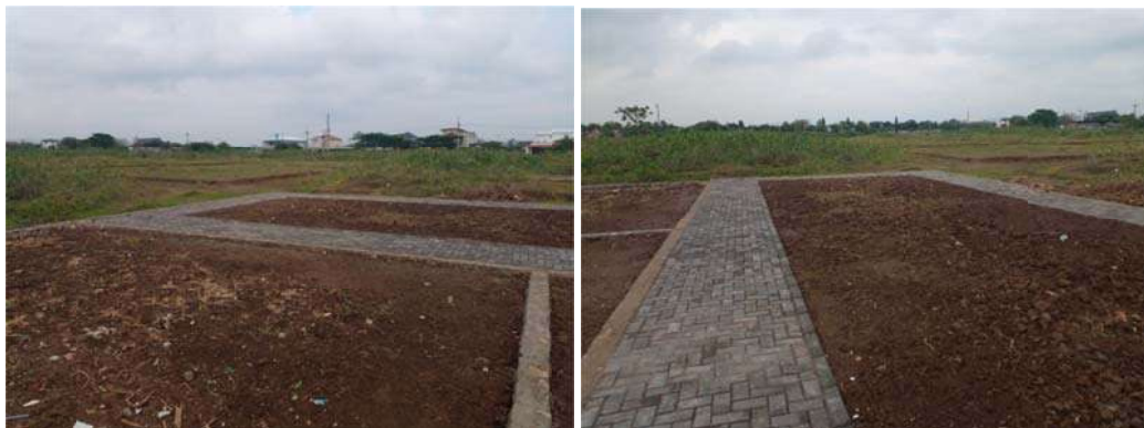
Gambar 4.4 Pembangunan Paving (Dana dari Developer ) (Sumber: Dokumentasi, September 2022)
