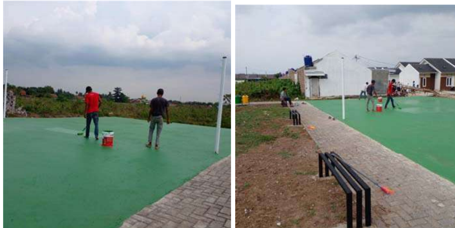
Gambar 4.10 Pengecatan Lapangan (Dana dari Developer ) (Sumber: Dokumentasi, November 2022)
