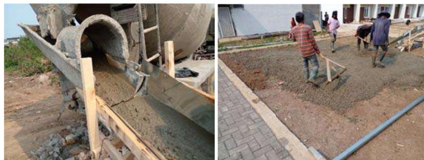
Gambar 4.6 Pengecoran (Dana dari Developer ) (Sumber: Dokumentasi, September 2022)
