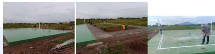
Gambar 3. Hasil Akhir Pembangunan Fasum Blok B Perumahan BIP dan Proses Pengecatan Garis Lapangan
