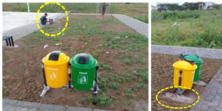
Gambar 4.8 Pemasangan Tong Sampah dan Pengecatan Bangku dan Fitness Outdoor (Dana dari LPPM Untar) (Sumber: Dokumentasi, Oktober 2022)
