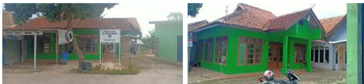
Gambar 4.1 Kondisi Majelis Taklim Al Musa'adah Sesudah Renovasi (Sumber: Dokumentasi, November 2020)
