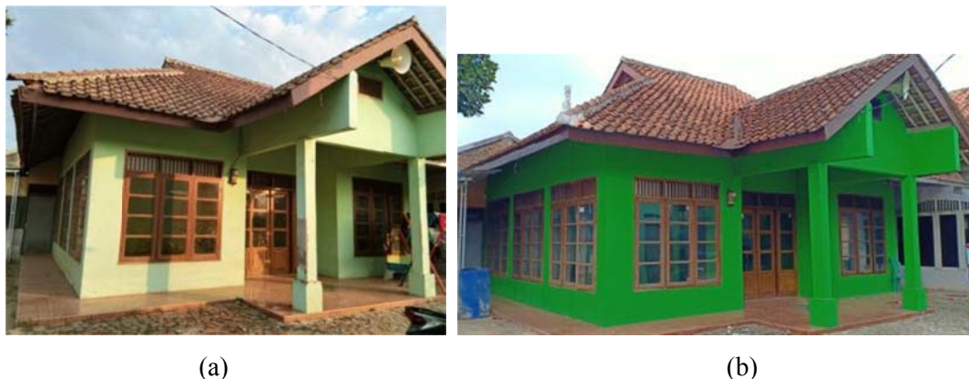
Gambar 1.3 Kondisi Bangunan Majelis Taklim Al Musa'adah: (a) Sebelum Renovasi; (b) Sesudah Renovasi (Sumber: Dokumentasi, Agustus 2019 dan Agustus 2020)
