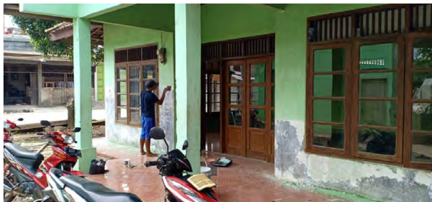
Gambar 4.3 Pekerjaan Plamir Tembok (Sumber: Dokumentasi, April 2020)
