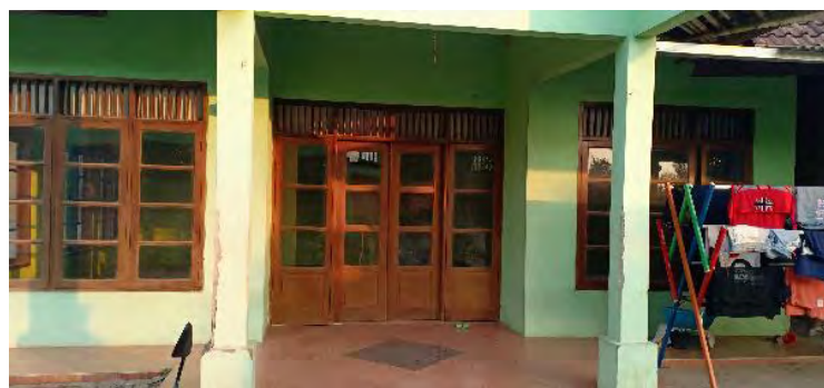
Gambar 6. Pintu Masuk Majelis Taklim Al Musa'adah (Sumber: Dokumentasi, Juli 2019)
