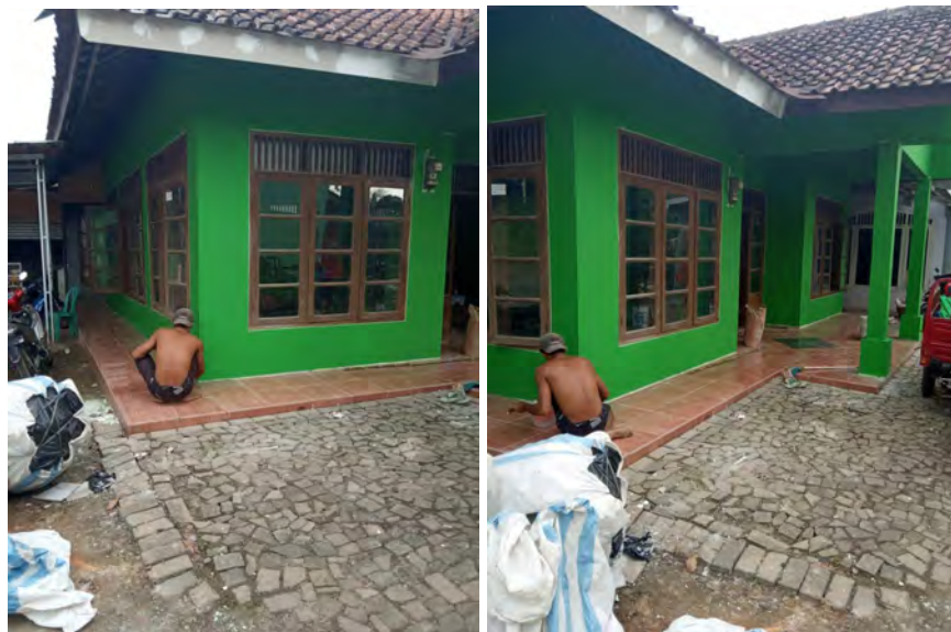
Gambar 4.5 Pengecatan Dinding dan Perbaikan Lisplang (Sumber: Dokumentasi, April 2020)
