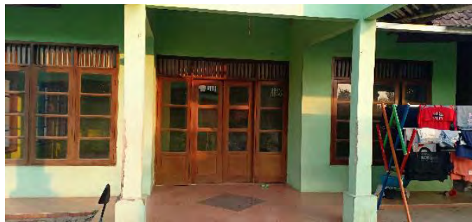
Gambar 1.13 Pintu Masuk Majelis Taklim Al Musa'adah (Sumber: Dokumentasi, Juli 2019)
