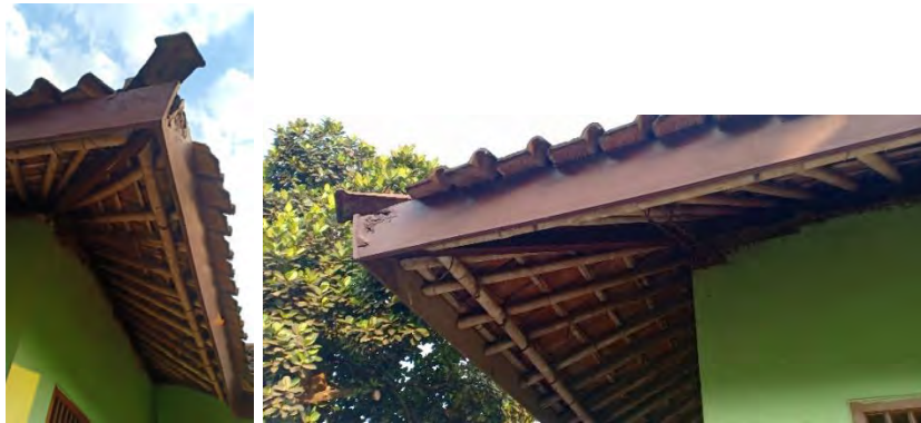
Gambar 2.1 Kondisi Atap dan Lisplang di Lapangan (Sumber: Survei, Juli 2019)
