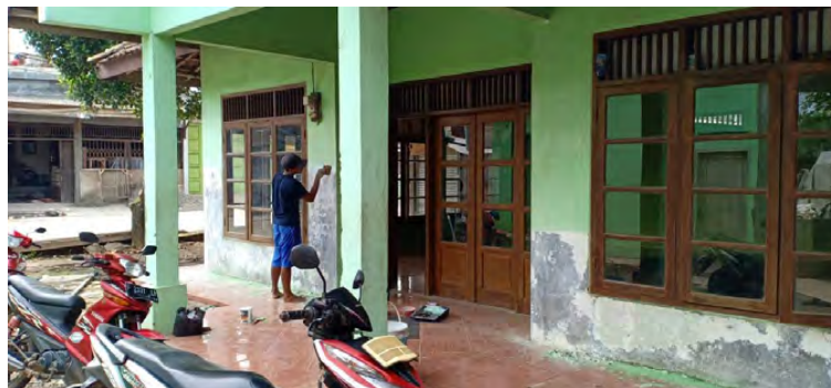
Gambar 11. Pekerjaan Plamir Tembok (Sumber: Dokumentasi, April 2020)
