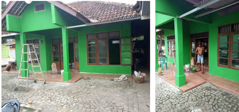
Gambar 4.6 Pengecatan Dinding Eksterior (Sumber: Dokumentasi, April 2020)
