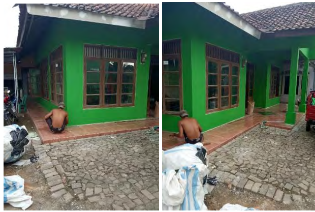
Gambar 13. Pengecatan Dinding dan Perbaikan Lisplang (Sumber: Dokumentasi, April 2020)
