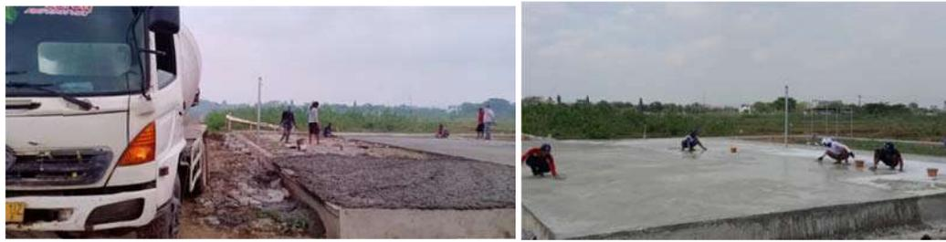
Gambar 4.7 Pengecoran dan Perapian Cor Beton (Dana dari *Developer*)
