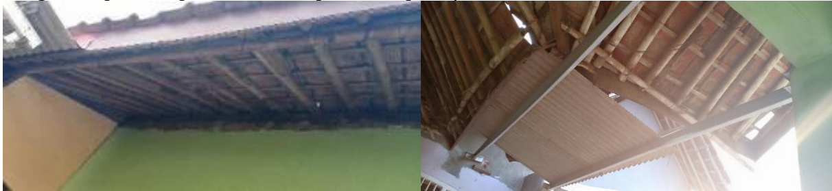
Rangka Atap Terekspos karena Tanpa Penutup Plafon
