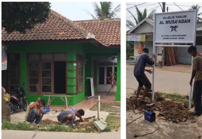
Gambar 13. Penggalian Tanah untuk Pondasi dan Pemasangan papan Nama (Sumber: Dokumentasi, Agustus 2020)
