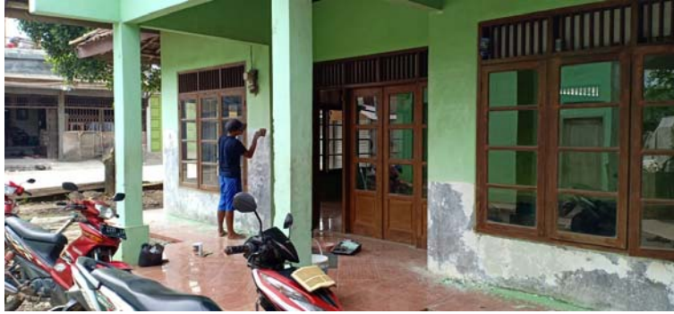
Gambar 9. Pekerjaan Plamir Tembok (Sumber: Dokumentasi, April 2020)
