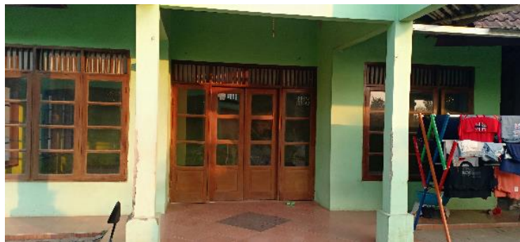
Gambar 4. Pintu Masuk Majelis Taklim Al Musa'adah (Sumber: Dokumentasi, Juli 2019)
