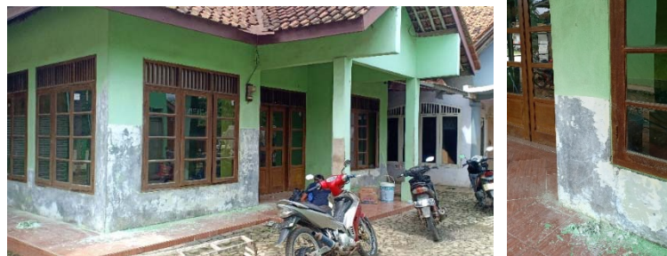
Gambar 8. Pengerokkan Dinding (Sumber: Dokumentasi, April 2020)
