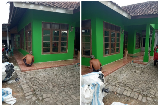
Gambar 11. Pengecatan Dinding dan Perbaikan Lisplang (Sumber: Dokumentasi, April 2020)
