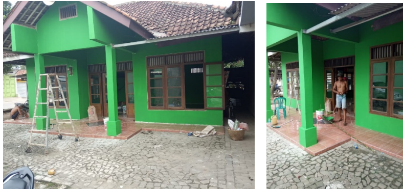
Gambar 12. Pengecatan Dinding Eksterior (Sumber: Dokumentasi, April 2020)
