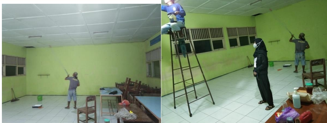
Gambar 5. Tahap pengecatan pada interior Sumber : Penulis, 2022
