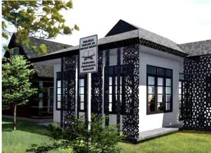
Gambar 6. Rencana Desain Alat Pembayang/*Shading Device*
