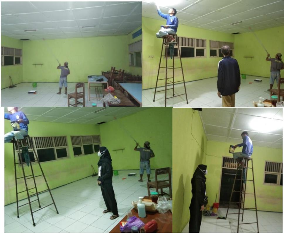
Gambar 4.5. Tahap pengecatan pada plafon
