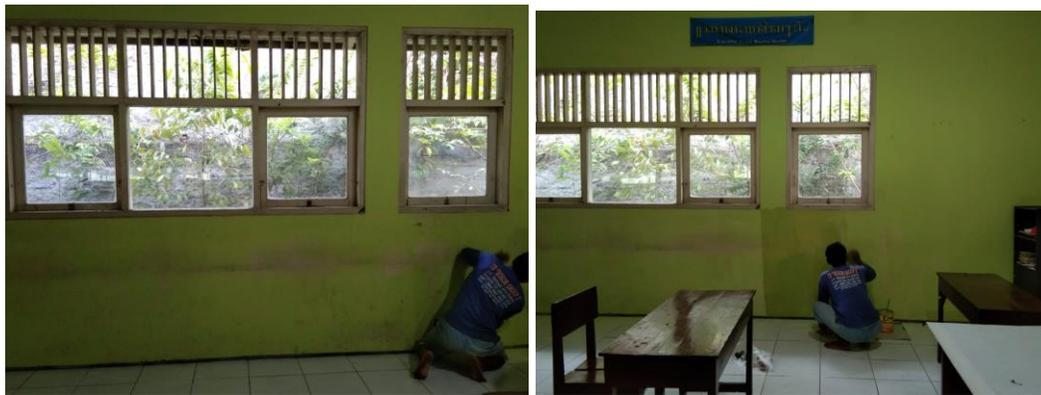
Gambar 4.4. Tahap pengecatan pada interior dinding
