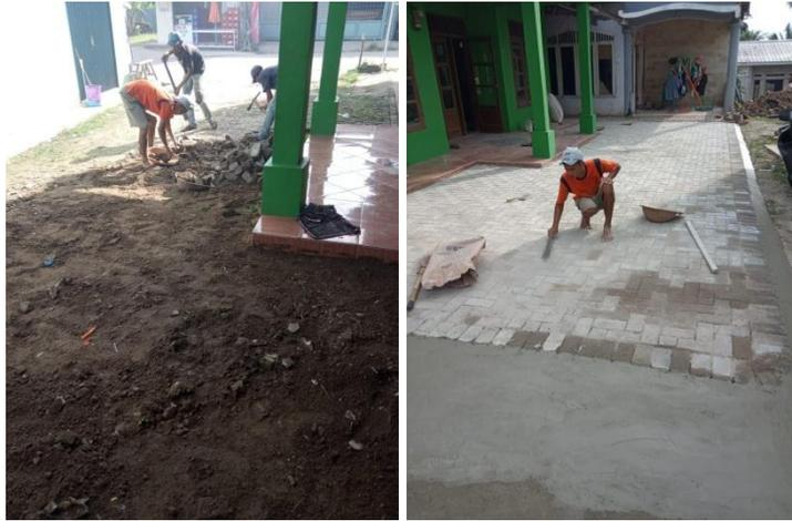
Gambar 4. Proses pemasangan *paving block*
