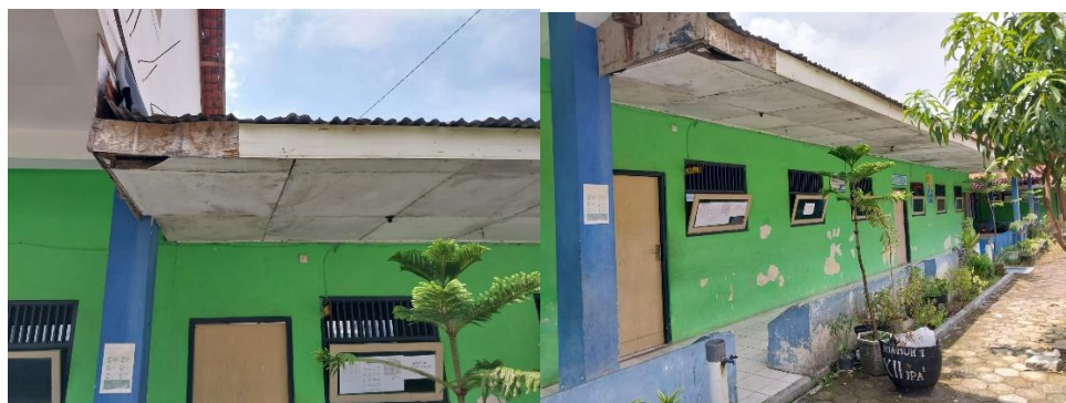
Gambar 1. Eksisting TPA AL Munawwaroh Blora
