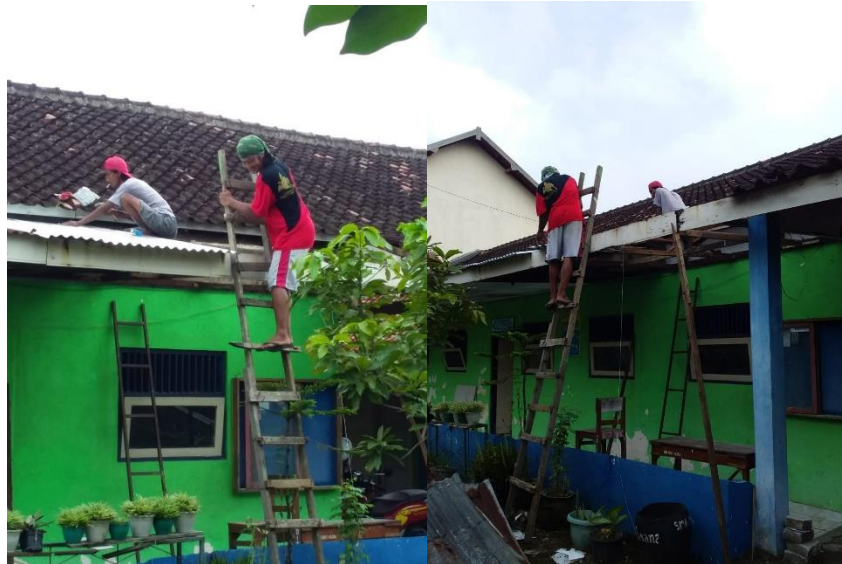
Gambar 2. Tahap pembongkaran material lama (penutup atap)
