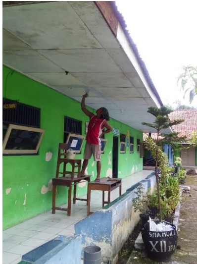
Gambar 3. Tahap pengecatan plafon
