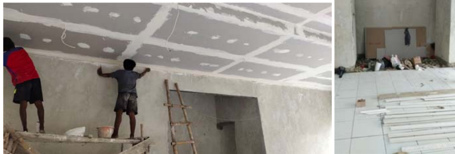
Gambar 1.4 Kondisi Pembangunan Interior Mushola Al-Abror (Sumber: Dokumentasi, Januari 2021)
