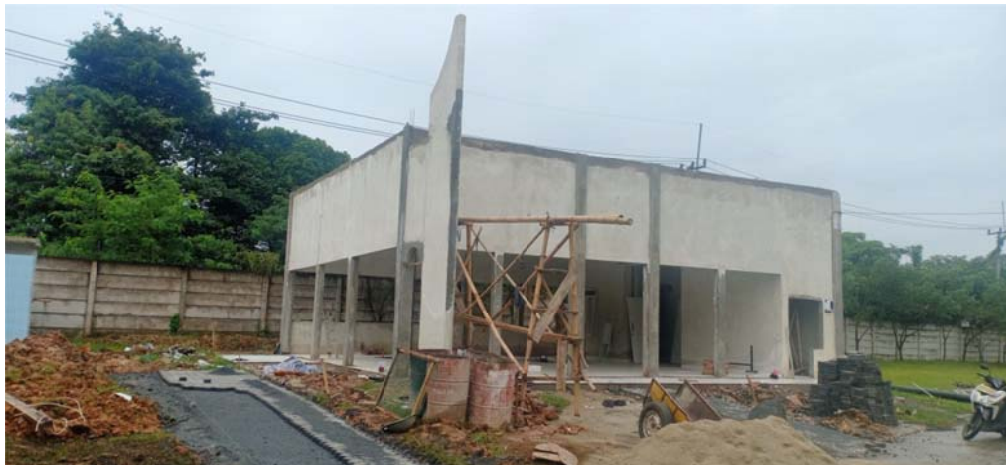
Gambar 1.3 Pembangunan Mushola Al-Abror (Sumber: Dokumentasi, Januari 2021)
