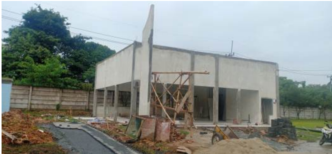
Gambar 1. Pembangunan Mushola Al-Abror Sumber: Dokumentasi, Januari 2021
