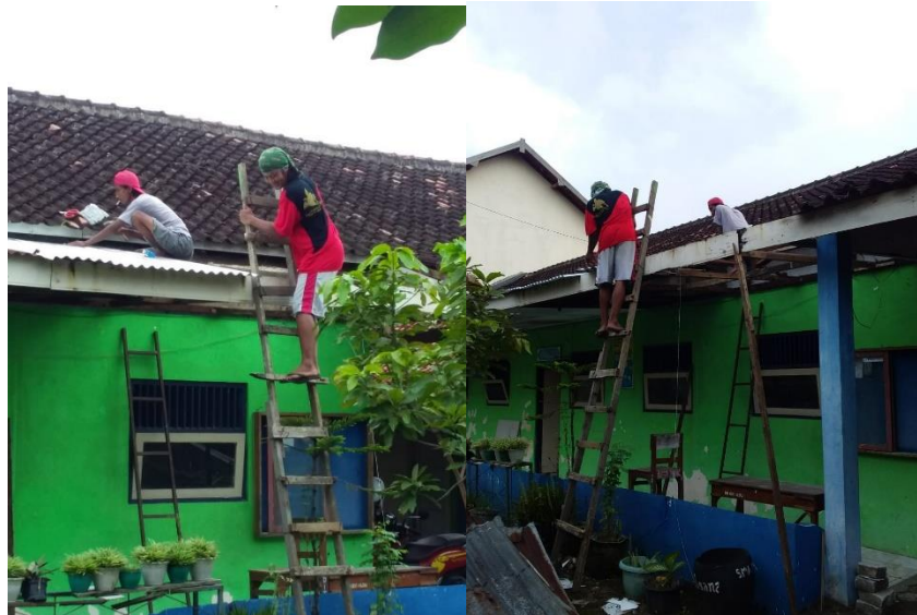
Gambar 2. Tahap pembongkaran material lama (penutup atap)
