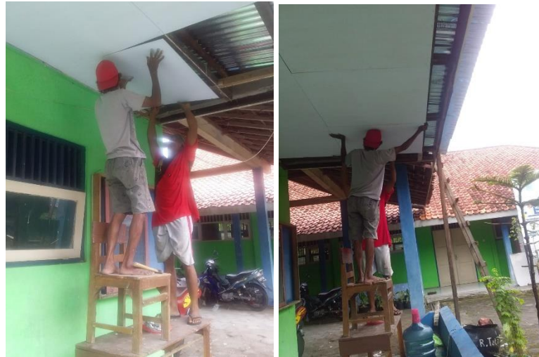
Gambar 4. Tahap pemasangan plafon baru
